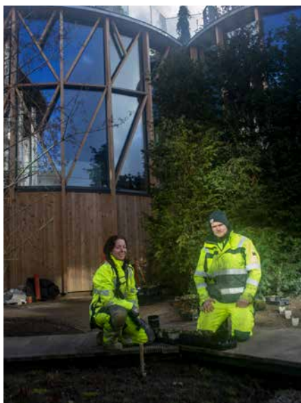
Jesper Fog og Sandra Piil Thomsen har begge været en del af et hold på syv anlægsgartnere, som har arbejdet med at anlægge den 9000 m 2 store eventyrhave siden august 2020. Her er de i gang med finjusteringer i en af de to nedsænkede haver omkring museet.
