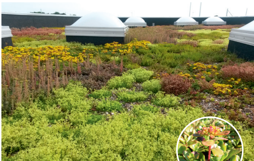
Biodiversitet, temperaturregulering og bæredygtig regnvandshåndtering – på et og samme tag.
